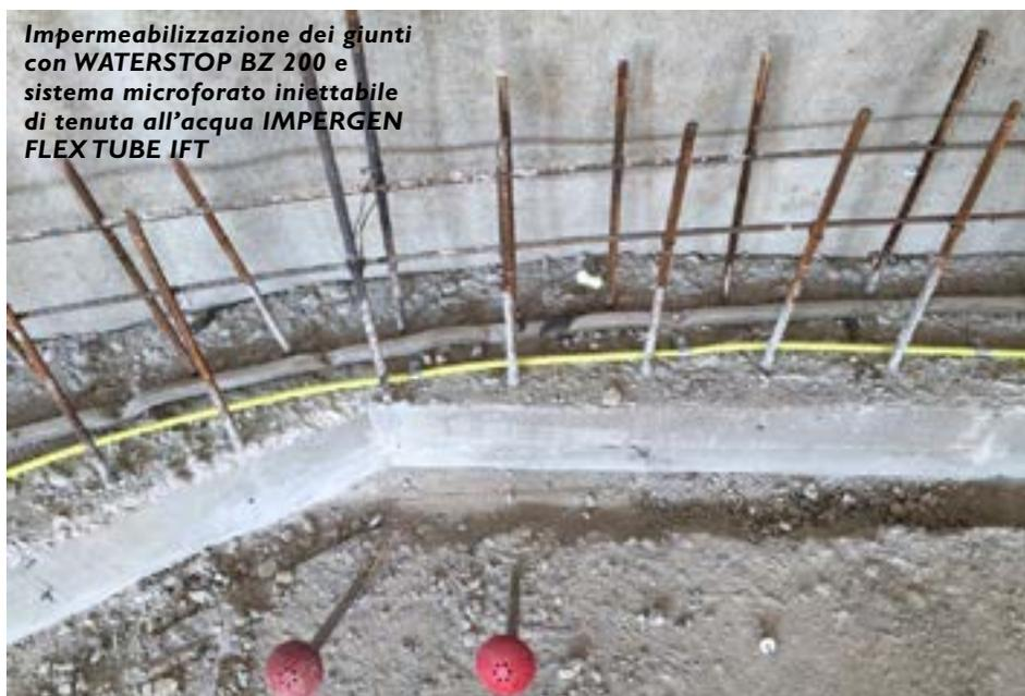
**Impermeabilizzazione dei giunti con WATERSTOP BZ 200 e sistema microforato iniettabile di tenuta all'acqua IMPERGEN FLEX TUBE IFT**
